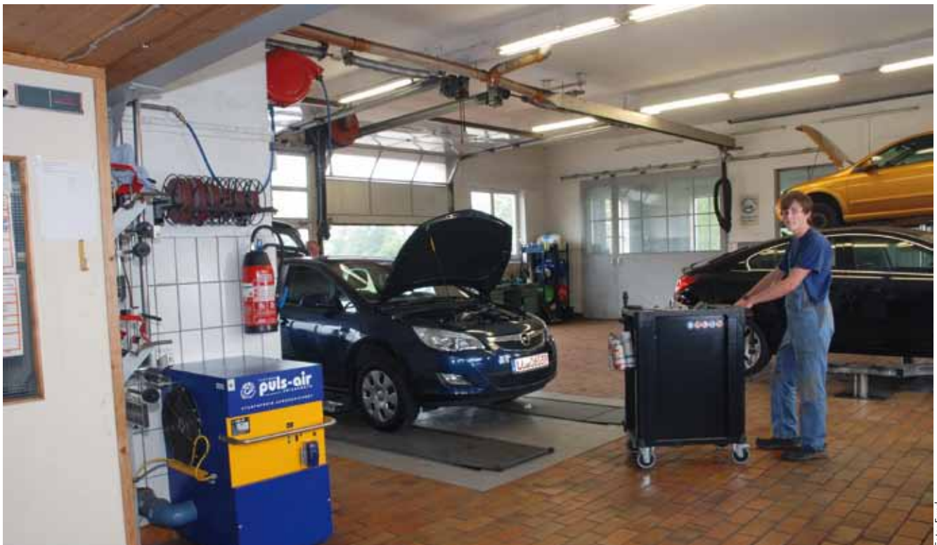
Vom blauen Heizgerät links in der Ecke der Opel-Werkstatt strömt die warme Luft zu den Arbeitsplätzen der Mechaniker – zu denen auch Kfz-Meister Florian Dietrich zählt.
